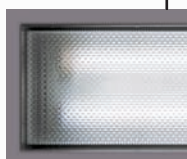
Bündig eingelassene Beleuchtung.
