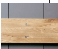
Stoßleisten aus Hartholz.
